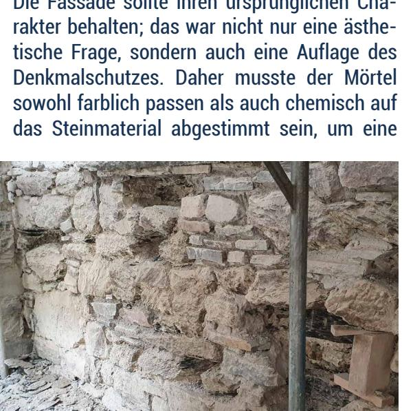
lange Haltbarkeit zu erzielen. Ein Bauchemiker als Mörtelspezialist beriet entsprechend, testete den verwendeten Mörtel und gab ihn zur Verwendung frei. Um die neuen Fassadenbereiche mit den Grundmauern gut zu verbinden, wurden fallweise zusätzlich Stahlanker eingebaut.
